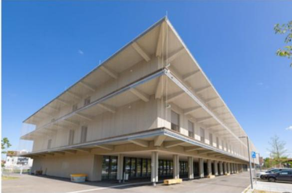
*Holz- und Holzbaustoffe finden sich in der Fuchshofschule in nahezu allen Bauteilen: an und in den Fassaden, im Decken- und Dachaufbau sowie im Atrium.*
