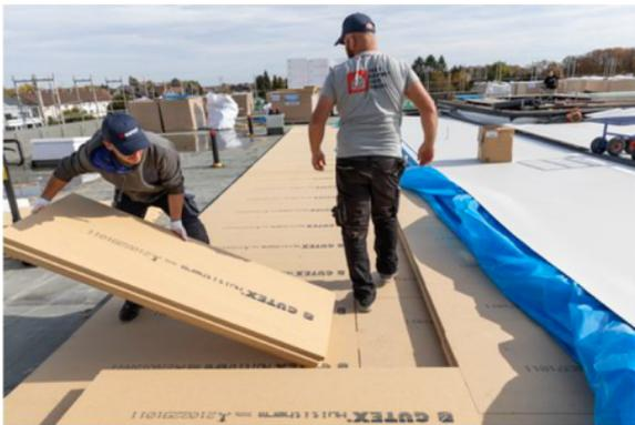
*Um eine mittlere Dämmstärke von 15 cm zu erreichen, werden die GUTEX Multitherm Platten teils einlagig, in einigen Bereichen zweilagig und an der höchsten Stelle sogar dreilagig verlegt. Nut und Feder-Kanten erleichtern die schnelle Verarbeitung.*
