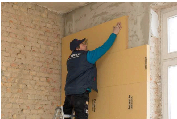
Montage GUTEX Thermoroom: Die Holzfaserdämmplatten werden vollflächig mit Klebe- und Spachtelputz verklebt. Foto: Martin Granacher/GUTEX
