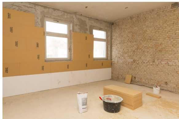
GUTEX Thermoroom Innendämmung im denkmal- geschützten Bahnhofsgebäude. Foto: Martin Granacher/GUTEX
