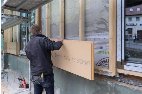
*Durio ist ein bauphysikalisch durchdachtes System, das eine einfache und schnelle Installation und Befestigung ermöglicht – sowohl auf EPS- und Mineralwolldämmung als auch auf rissigem Mauerwerk oder Fachwerk lassen sich wärmebrückenfreie, zukunftsfähige Fassaden für Ein- und Mehrfamilienhäuser umsetzen. @GUTEX/Martin Granacher*
