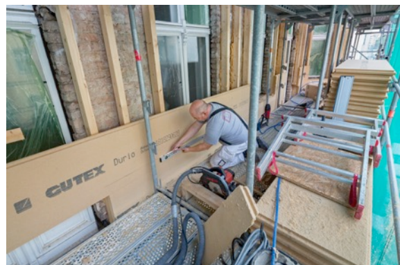
Das GUTEX Durio Fassadendämmsystem besteht aus einer tragenden Holzkonstruktion und den speziell entwickelten Dämmplatten GUTEX Durio Thermowall aus ökologischen Holzfasern.
