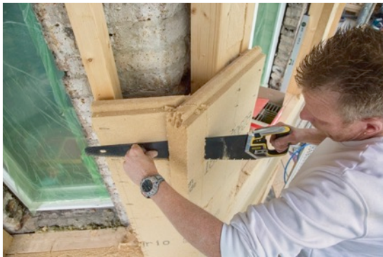
Die Holzfaserdämmplatten GUTEX Durio Thermowall ließen sich vor Ort mit einer gängigen Dämmstoffsäge zuschneiden.
