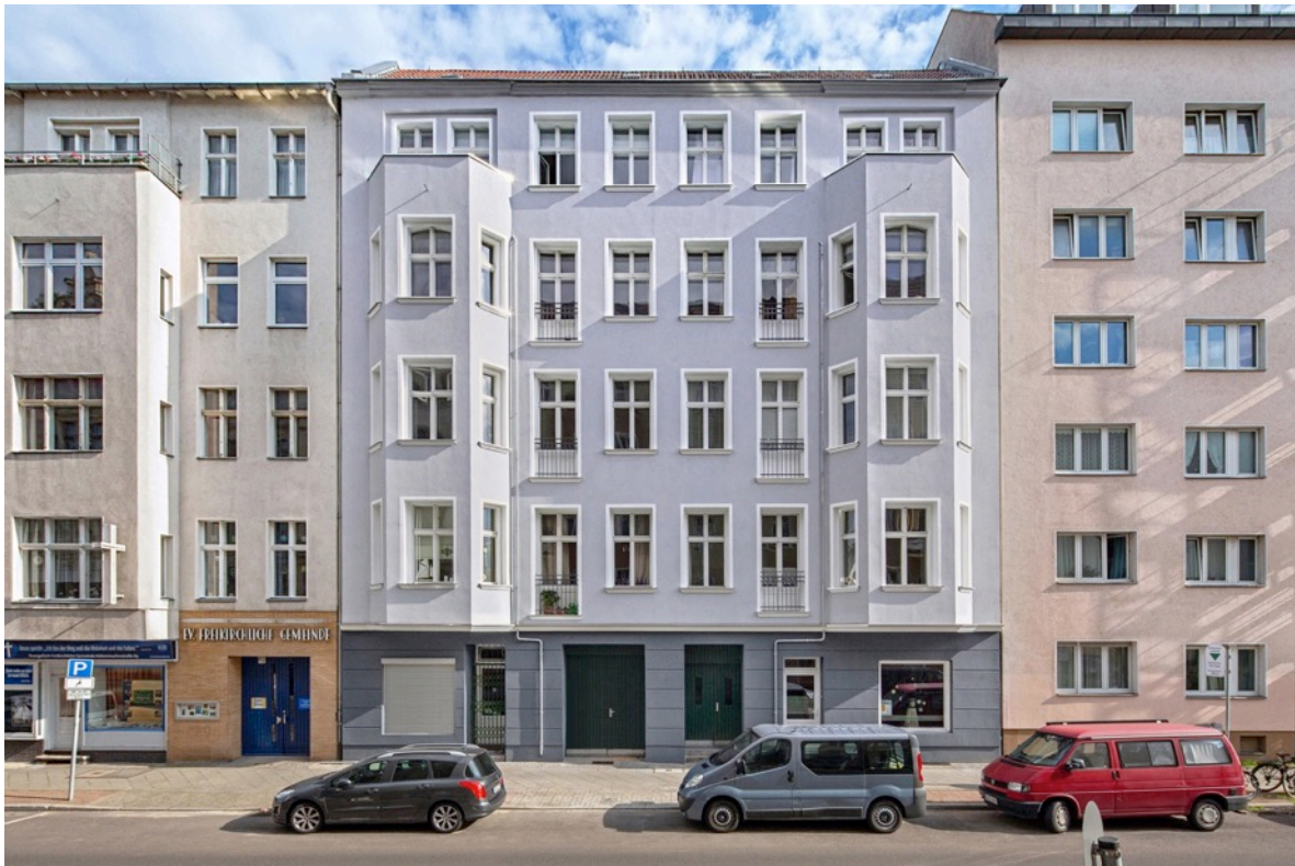
Das 5-geschossige Gebäude in Berlin-Schöneberg erstrahlt in neuem Glanz.
