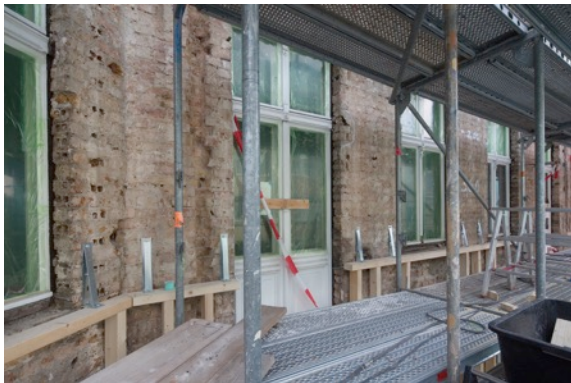
Die speziellen Durio-Winkel dienen der Befestigung des Holzständerwerks.
